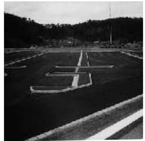
急ピッチで進むワイナリー施設駐車場は舗装完了
