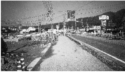
甲山橋工事現場
