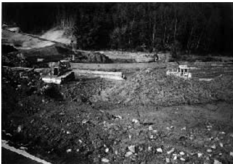
急ピッチですすむ箱地区ほ場整備
