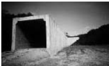
盛土を待つ大型ボックスカルバート
