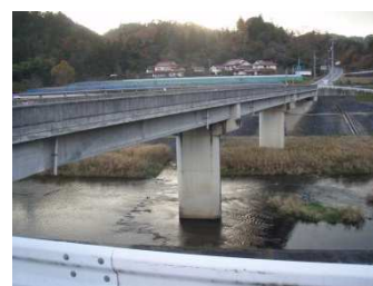
川塚大橋 L=103.7m (PC 橋) 1991 年架設
