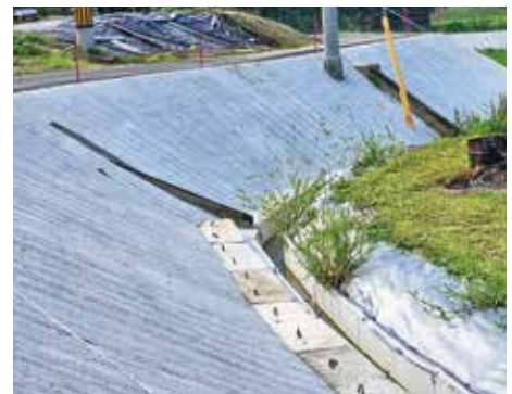
防草コンクリートによる雑草対策
