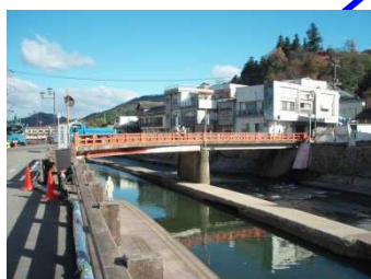
高野橋 L=27.3m (鋼橋) 1964年架設
