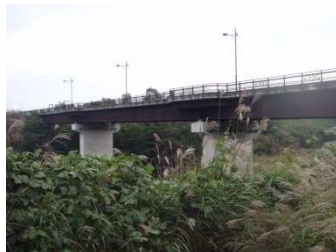
香遊大橋 L=130m (鋼橋) 1999年架設
