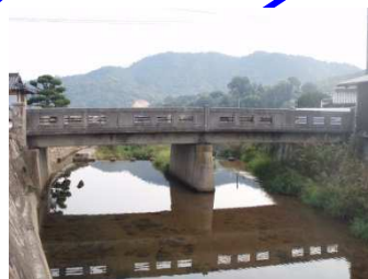
陰陽橋 L=15.7m (RC橋) 1954年架設
