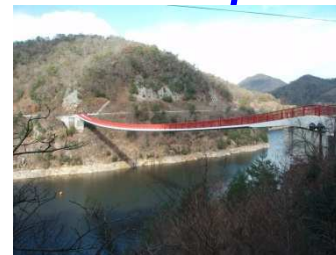
夢吊橋 L=172.6m (PC橋) 1996年架設
