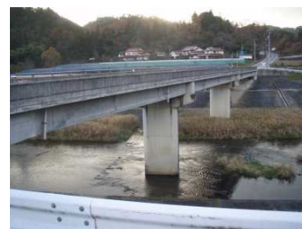
川塚大橋 L=103.7m (PC橋) 1991年架設
