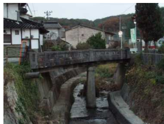
木梨橋 L=12.9m (RC橋) 1935年架設
