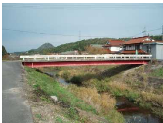
小国橋 L=24.2m (鋼橋) 1963 年架設
