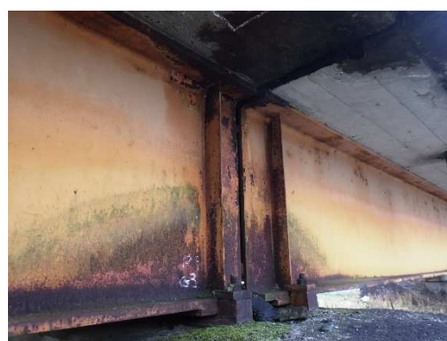
主桁の腐食・防食機能の劣化
