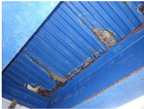
鋼床版の腐食・欠損
