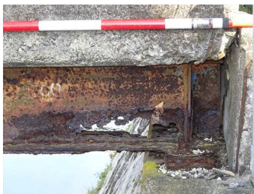
主桁の腐食・防食機能の劣化
