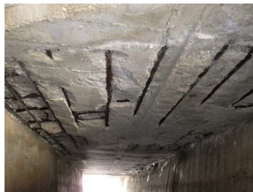
コンクリート床版の鉄筋露出
