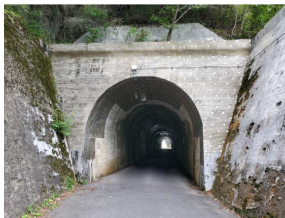
【見堂平トンネル】
