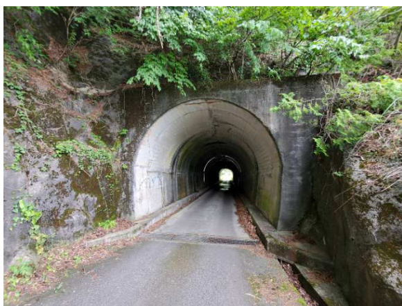
【城ヶ平トンネル】
