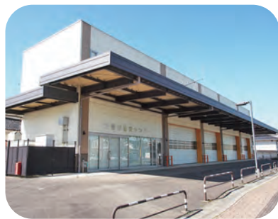
防災センター
