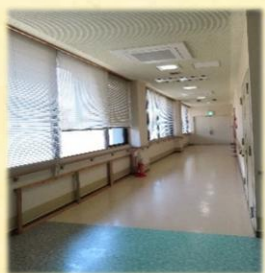
多目的集会室北側通路
