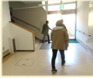
自治センター北側出入口
