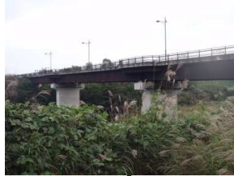
香遊大橋 L=130m (鋼橋) 1999 年架設
