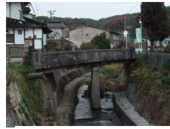
木梨橋 L=12.9m (RC 橋) 1935 年架設
