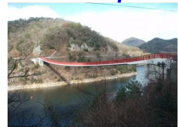
夢吊橋 L=172.6m (PC 橋) 1996 年架設
