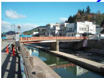
高野橋 L=27.3m (鋼橋) 1964 年架設
