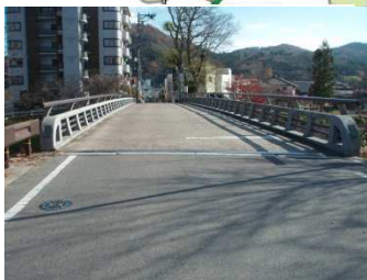
榎橋 L=44.9m (RC 橋) 1958 年架設
