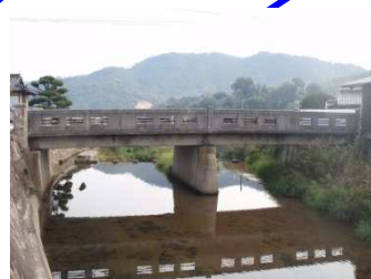
陰陽橋 L=15.7m (RC 橋) 1954 年架設
