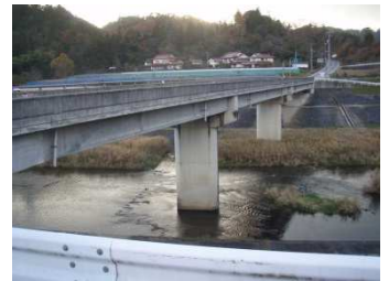
川塚大橋 L=103.7m (PC 橋) 1991 年架設
