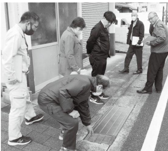
経年劣化が激しい集落排水路
