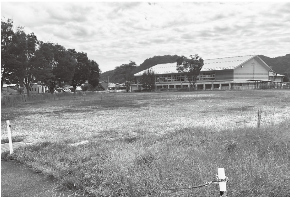
建設が始まる新学校給食センター
