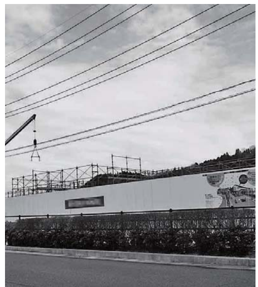
建設が進むマリオットホテル
