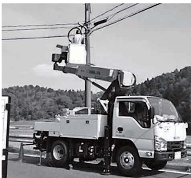
光ファイバケーブル敷設工事
